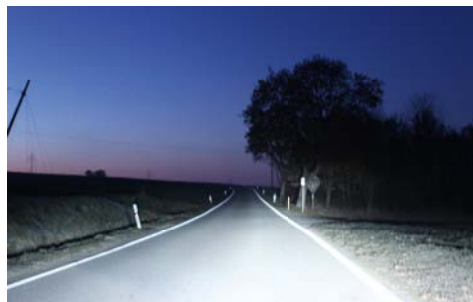
Fahrbahnmarkierung für gute Sicht bei Dunkelheit. Umgesetzt bei Untermettenbach im Oktober 2017
